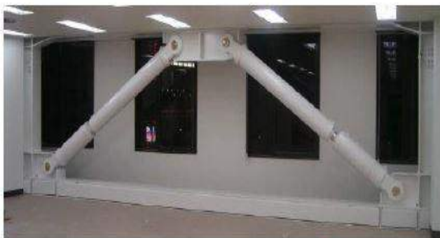
制振ブレース補強 ガセットプレートに取付ける補強プレートの現場溶接をさけるため、ブレース材を鋼管部とダンパ一部に分割する方法を採用。
