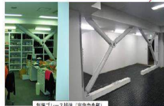
制振ブレース補強 (室内中央部)
