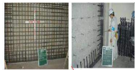
壁の打ち増し補強 ノンアンカーRC壁接着工法の採用により、騒音・振動・粉塵などの発生を低減。
