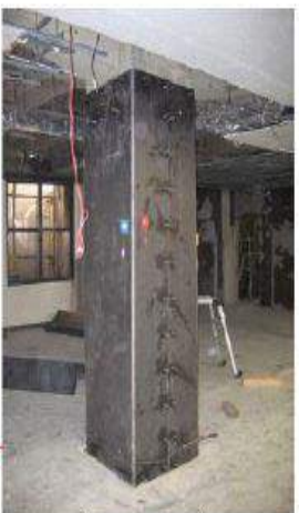
柱鋼板補強 コ字型に加工した鋼板を現場にて溶接し、無収縮モルタルを注入。
