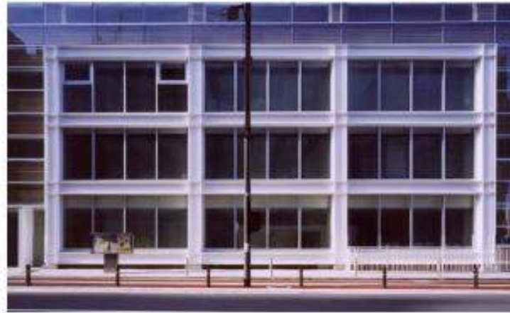
PG 工法による外貼り補強部の詳細
