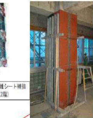
柱鋼板補強
