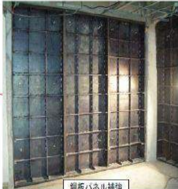
鋼板パネル補強 搬入可能な大きさに分割した鋼板パネルを、現場において高力ボルトで緊結し一体化。既存躯体とはエポキシ樹脂により一体。
